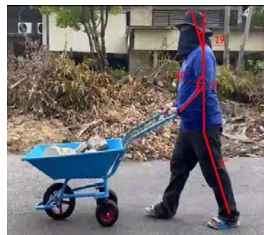
รูปที่ 3 ท่าทางการเข็นรถเข็นในงานก่อสร้างแบบปรับปรุงใหม่
