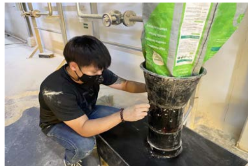
รูปที่ 2 การติดตั้งอุปกรณ์ช่วยลำเลียงฝุ่นของเครื่องร่อน
